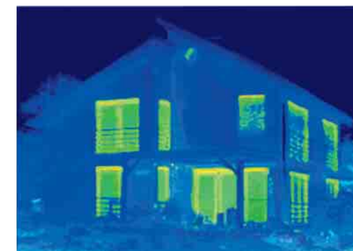
Nach dem sorgfältigen Einbau neuer Fenster aus dem Schüco LivIng Fenstersystem beweist die Thermografie den hohen energetischen Nutzen der Investition. Der ursprüngliche Energieverlust wird nahezu vollständig vermieden.
