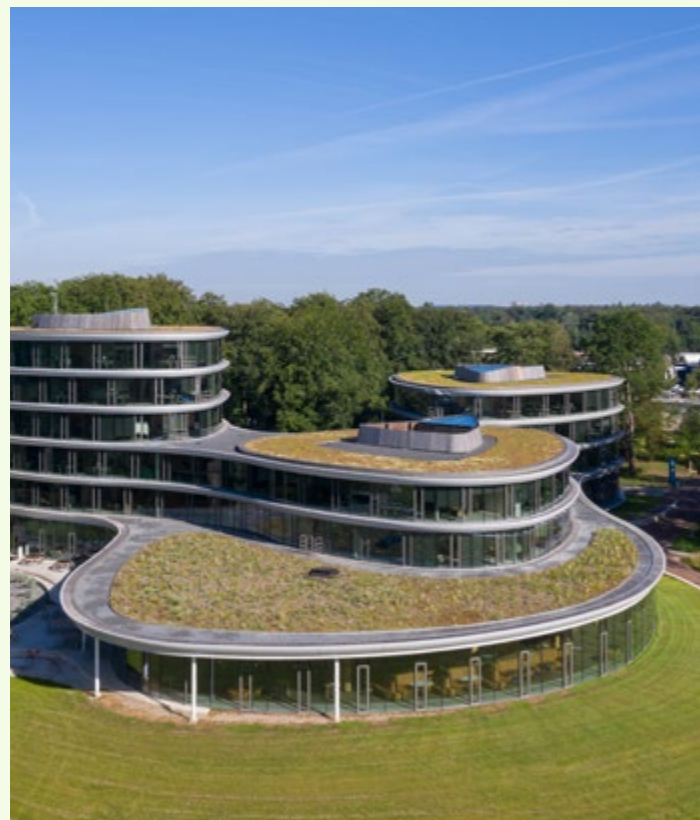
Das Bürogebäude der Triodos Bank in den Niederlanden setzt als komplett demontierbares, energieneutrales Gebäude mit einer Holzstruktur und einer verlasteten Aluminiumfassade international Maßstäbe für zirkuläres Bauen.
