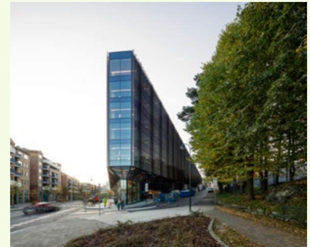
Gebaute Nachhaltigkeit: Der Neubau »Bjergersted Finansparken« in Stavanger, Norwegen, ist mit Gebäudezertifizierung BREEAM Outstanding für nachhaltiges Bauen ausgezeichnet.
