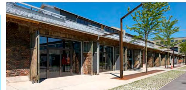
Teilen und zwei öffentbaren Flügeln. Die Architekten wählten das Stahlprofilssystem Janisol HI mit Isolierstegen aus glasfaserverstärktem Polyurethan. Seine hohe Wärmedämmung geht einher mit einer grossen mechanischen Stabilität, die aufgrund des zu erwartenden hohen Publikumsverkehrs ein weiteres Kriterium war. Die verwitterten Tore wurden bewusst sparsam repariert und vor die Verglasungen gesetzt. Sie haben keinen funktionalen Nutzen, sondern spiegeln die Geschichte des Gebäudes wider.
