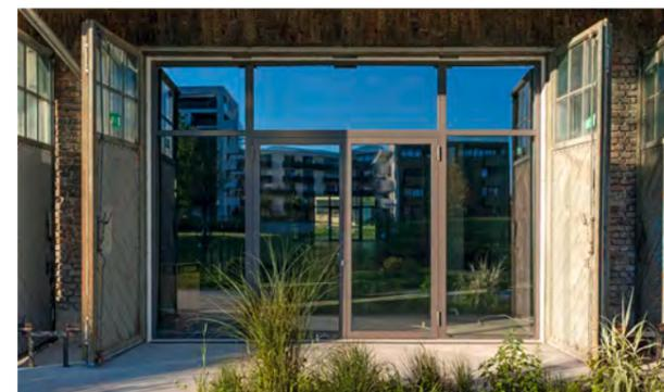
Neue Perspektiven, auch für den baulichen Brandschutz: Die insgesamt vier verglasten Atrien und Lufträume wurden bis zu einer Höhe von 420 cm mit Jansen VISS Fire EI90 ausgebildet, darüber erfolgte ein Weiterbau mit Jansen VISS Fire EI30.
