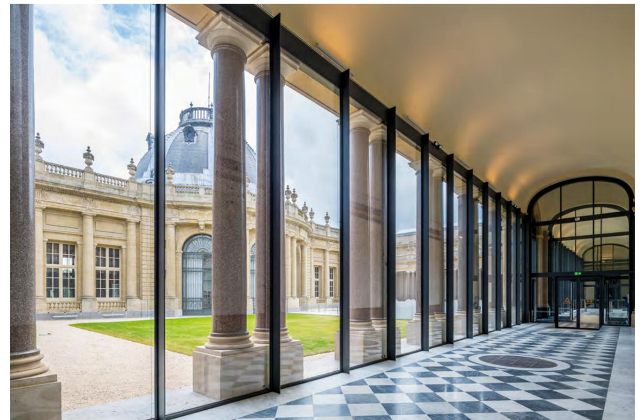
**Die Galerie ist abschnittsweise durch Glaseinbauten mit VISS Fire (EI60) und Janisol 2-Profilen (EI30) geteilt. Sie optimieren den Brandschutz und die Dämmung.**
