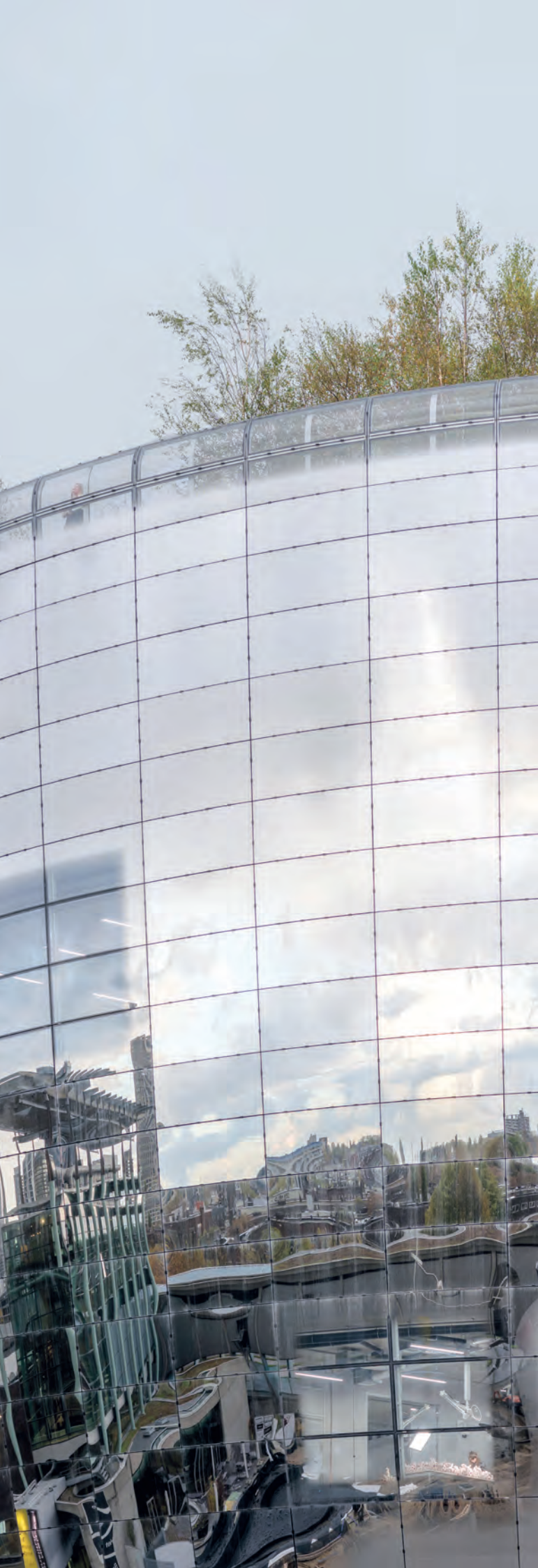
Die Befestigung der zweifach, teils dreifach gewölbten Paneele mittels speziell berechneter Anker erforderte umfangreiches Engineering vonseiten aller Beteiligten.
