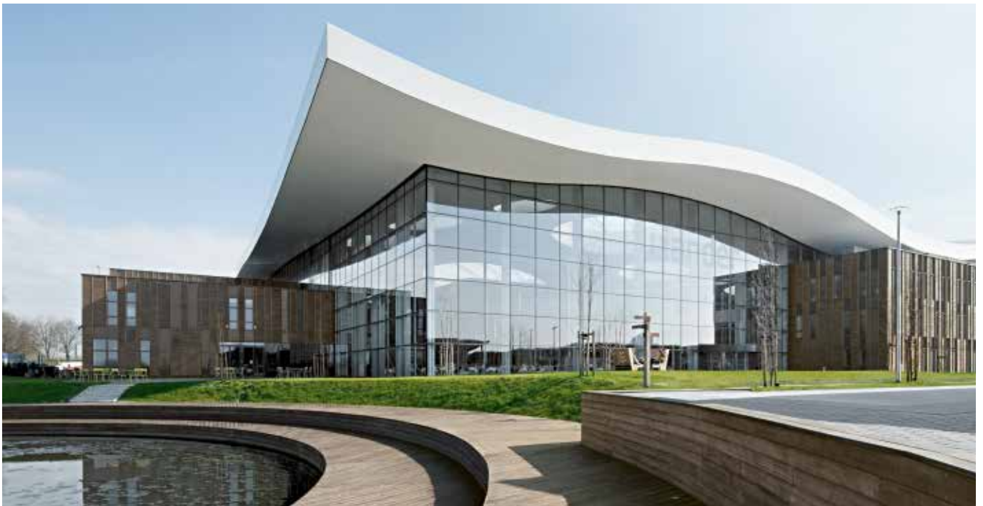
Aliander Headquarter, Duiven, Niederlande: BREEAM-Outstanding-zertifiziert, Schüco Systeme: Fassade FW60+
