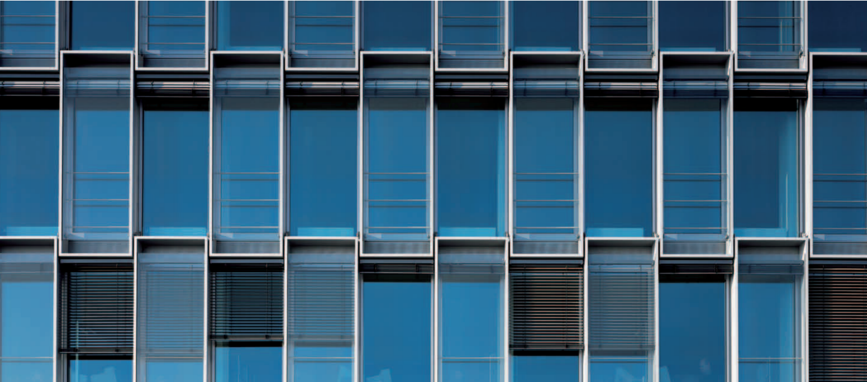
Das KAP am Südkai im Rheinauhafen in Köln. Hybridfassade mit aktivem Sonnenschutz bei gleichzeitiger Energie- und Komfortoptimierung Architekten: KSP Engel und Zimmermann, Köln "KAP am Südkai", Rheinau docks, Cologne. Hybrid façade with active solar shading for optimum energy use and convenience. Architects: KSP Engel und Zimmermann, Cologne
