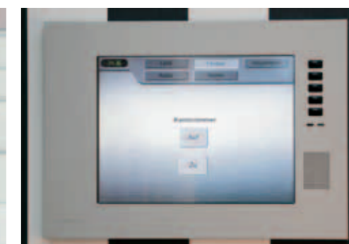
Das Ritz-Carlton in Wolfsburg: die Ver- und Entriegelung der Oberlichter dauert weniger als eine Sekunde The Ritz-Carlton in Wolfsburg: locking and unlocking of toplights takes less than one second
