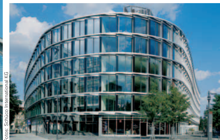
Theresienhöhe in München: Ganzheitliches Gebäudekonzept mit Hybridfassade heißt hier: Verknüpfung der Komponenten der Fassadentechnik mit denen der Beleuchtungstechnik sowie die Einbeziehung von RLT-Anlagen Architekten: KSP Engel und Zimmermann, Köln Theresienhöhe in Munich. An holistic building concept with hybrid façade here means connecting façade technology components with those for lighting technology and incorporating air conditioning systems. Architects: KSP Engel und Zimmermann, Cologne
