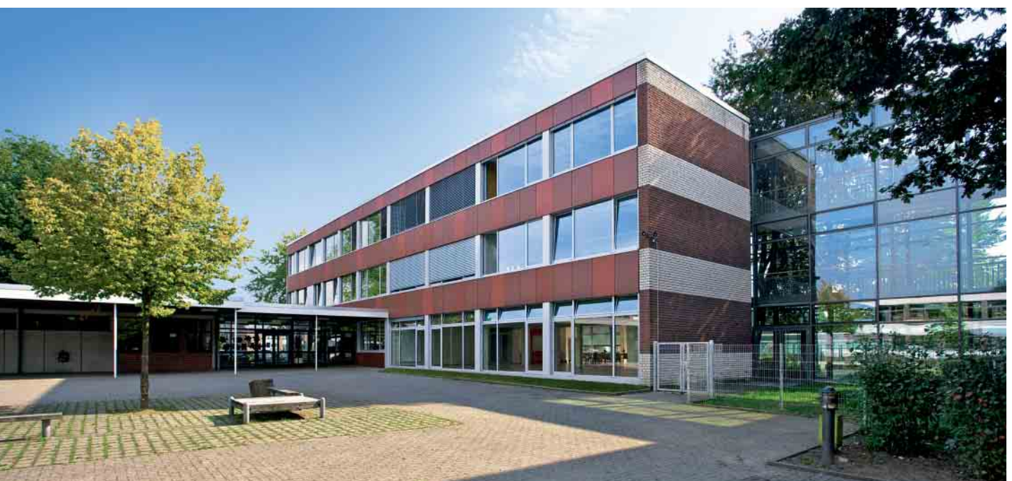
Oben: 40 Jahre lang prägten graue Faserzementtafeln das Gesicht der Walbert-Schule Unten: Heute gehen Fensterelemente, neue Fassadenverkleidung und Stirnseiten aus Backstein eine harmonische Verbindung ein.
