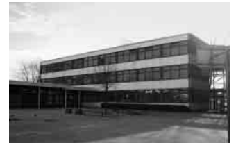
Oben: 40 Jahre lang prägten graue Faserzementtafeln das Gesicht der Walbert-Schule Unten: Heute gehen Fensterelemente, neue Fassadenverkleidung und Stirnseiten aus Backstein eine harmonische Verbindung ein.
