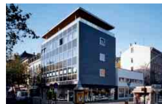
Salamander-Haus, Berlin (1998): Sanierung des unter Denkmalschutz stehenden Salamander-Gebäudes aus den 1960er-Jahren.
