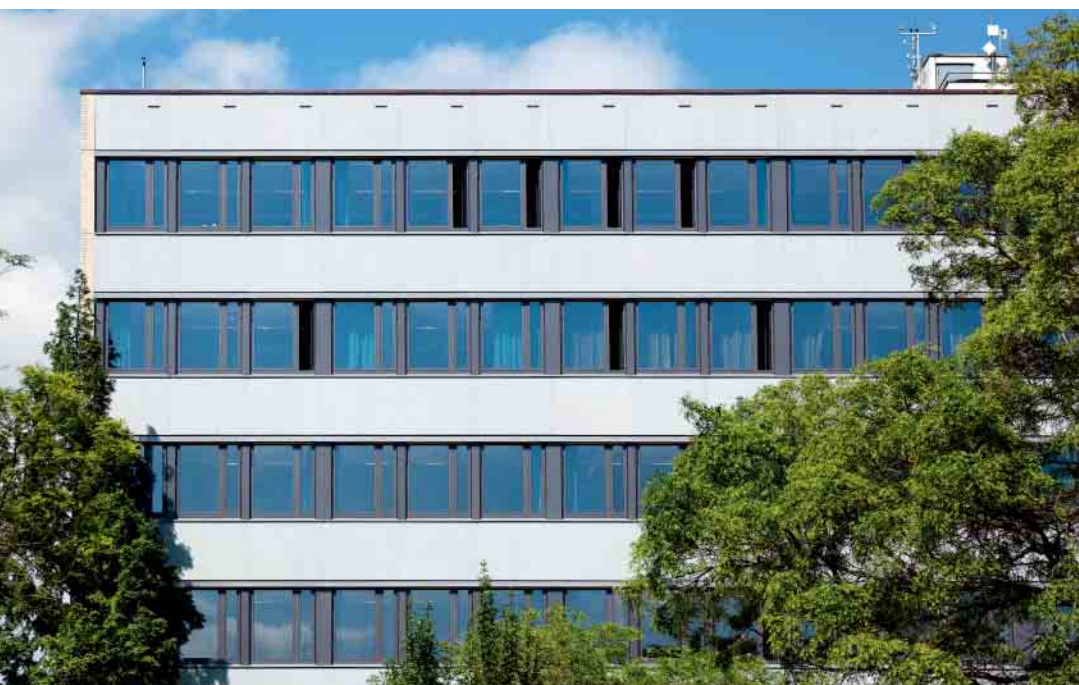
Die vorhandenen Schwingflügel wurden durch zweigeteilte Fensterelemente mit einem großen Dreh-Kipp-Flügel und einem schmalen Lüftungsflügel ersetzt.
