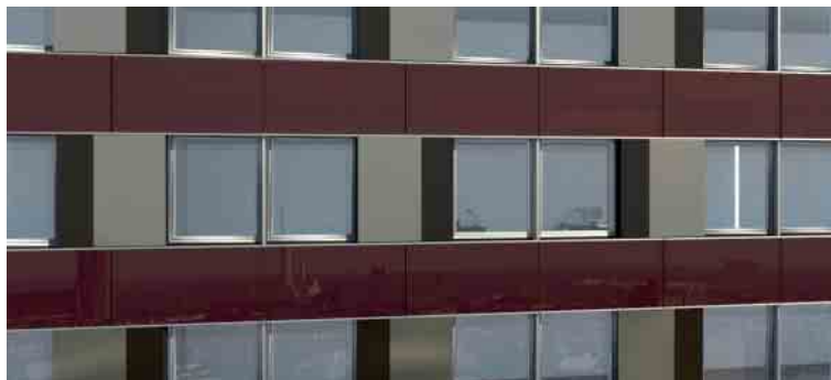
8. Ansicht der neuen Fassade 8. View of the new façade
