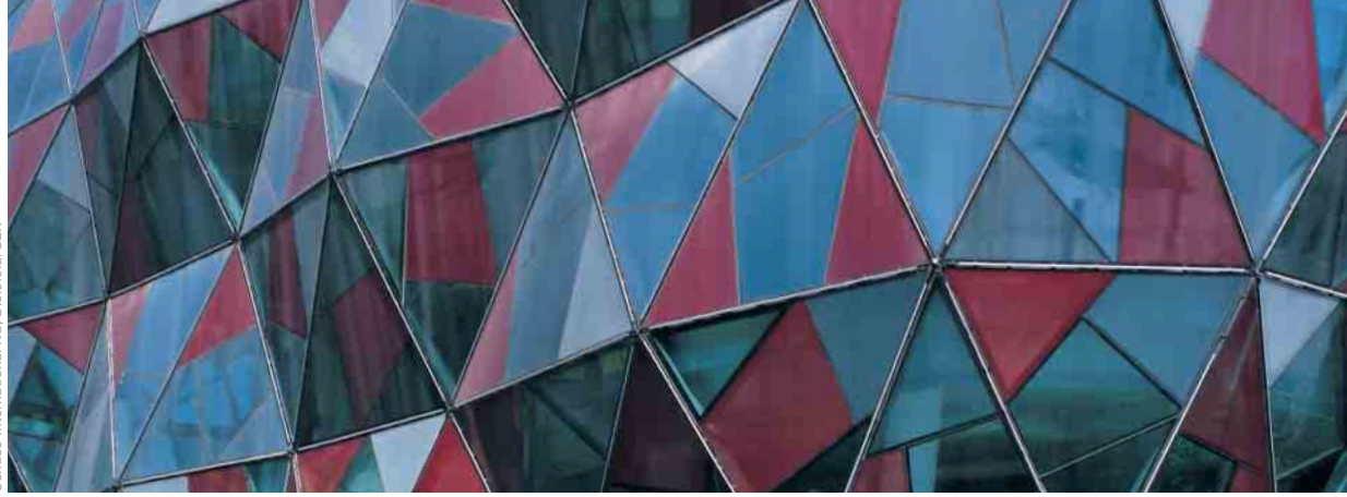
Die außergewöhnliche Gebäudehülle des „Gallery Building“ mit seiner Dreiecksstruktur The extraordinary envelope of the Gallery Building with its triangular structure
