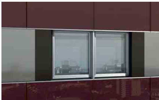
6. Montage der Füllungselemente im Kaltbereich 6. Installation of infill units in the cold area
