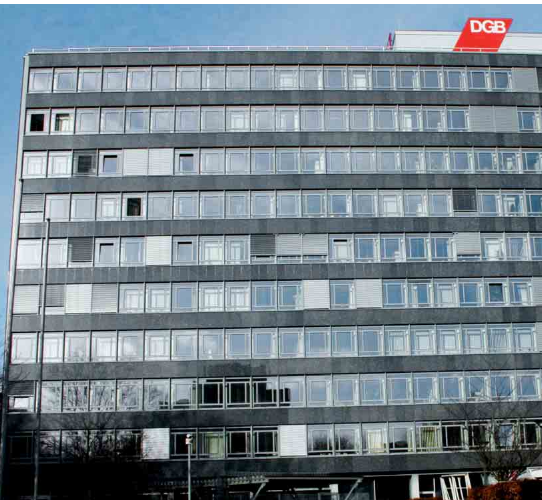
Links: Die bereits sanierte Südfassade. Die Natursteinplatten des Bestands wurden aufbereitet und wiederverwendet. Left: The refurbished south facade. The existing natural stone tiles were saved and re-used.
